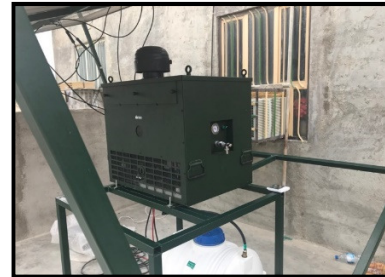
تصویر شماره ۱۱- اتصال منبع ذخیره آب به سیستم
