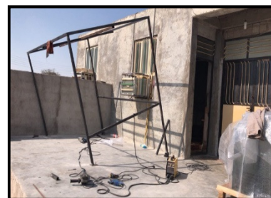
تصویر شماره ۹ - اجرای چهارچوب فلزی دستگاه و پنل خورشیدی
