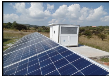
تصویر شماره ۳ - یک دستگاه تولید آب از هوای ۵۰۰ لیتری متصل به پنل های خورشیدی در روستایی در مکزیک (طراحی و اجرا توسط شرکت Eole Water فرانسه)
