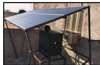
تصویر شماره ۲ - یک دستگاه تولید آب از هوای ۶۰ لیتری متصل به پنل های خورشیدی در روستای نغاشه جزیره قشم (طراحی و اجرا توسط شرکت سبز انرژی و شرکت Eole Water فرانسه)
